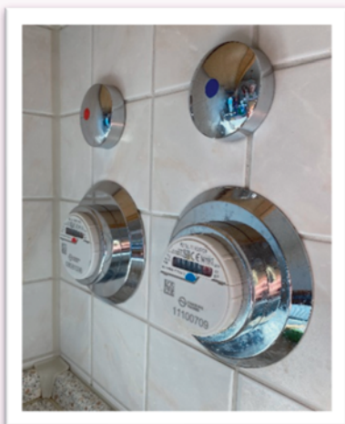
Wasserzähler/-uhren und Netzwerknoten
